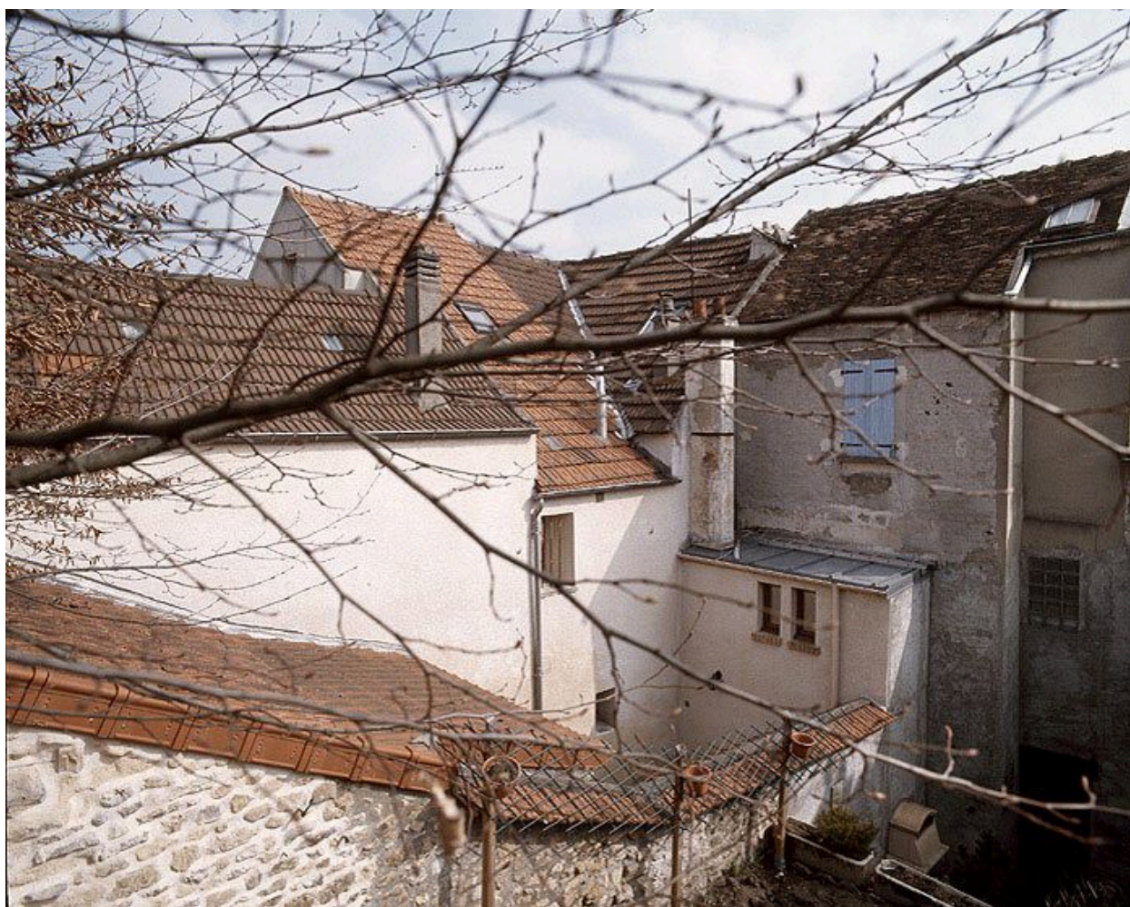
Vue d'ensemble du mur ouest de l'aile en retour.
