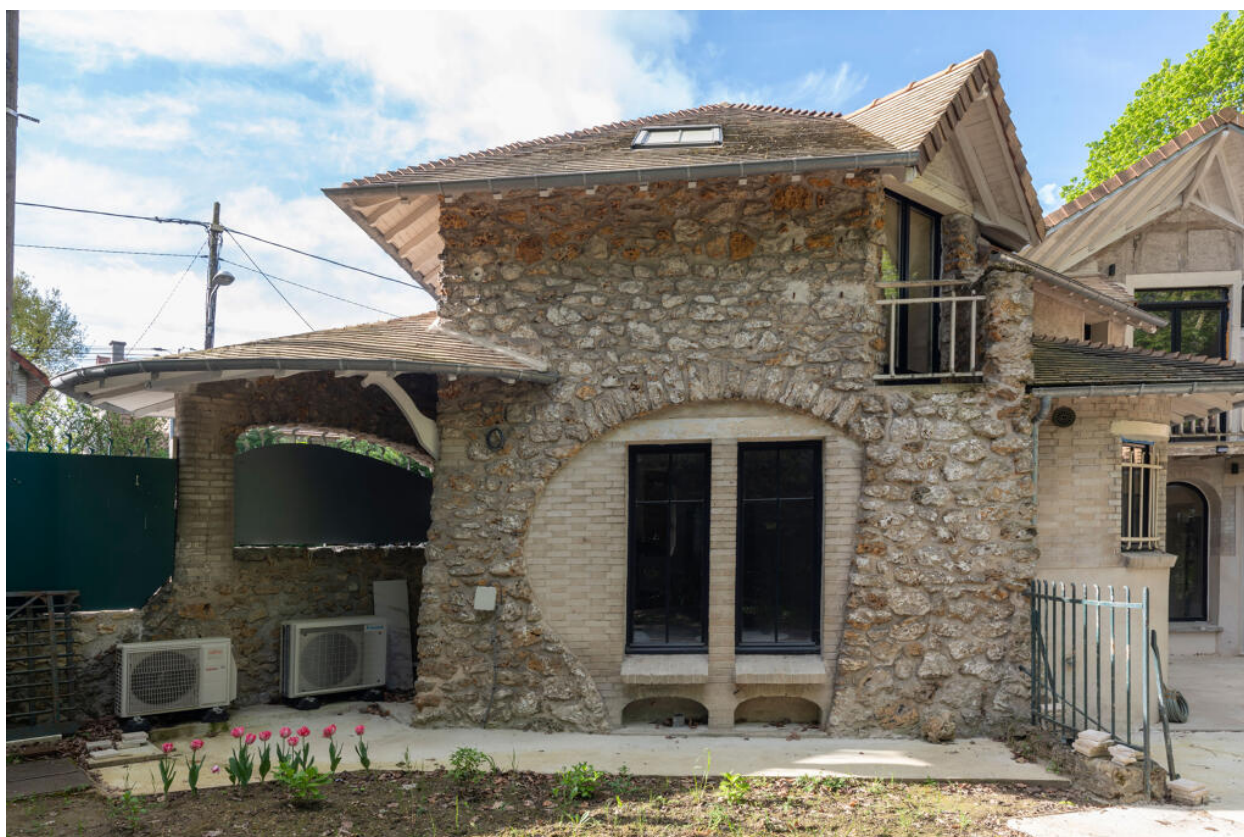
Avant-corps gauche de la façade nord-est de la dépendance.
