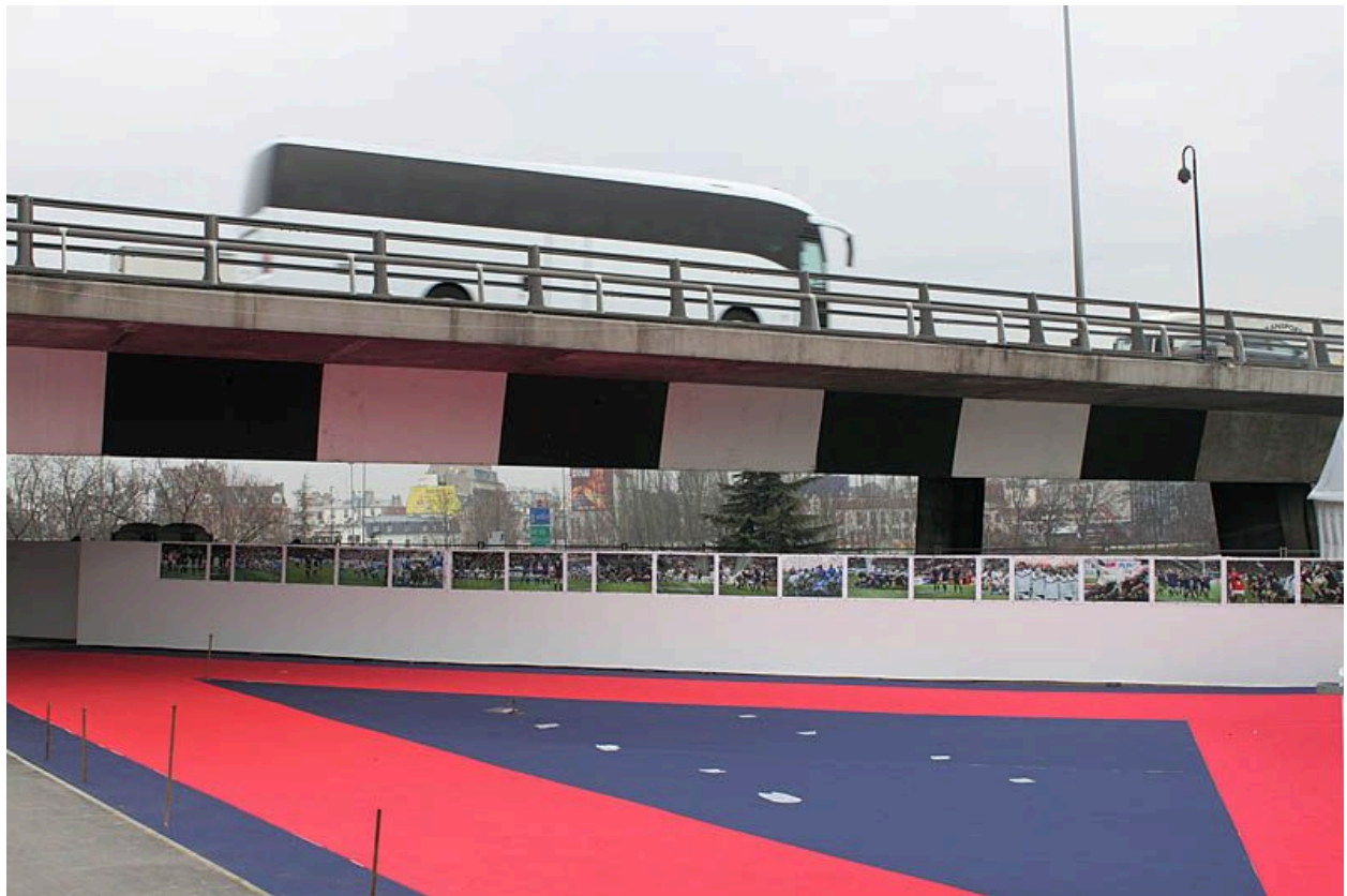
93, Saint-Denis. Dessous du viaduc de l'autoroute du nord A1 au niveau du Stade de France.
