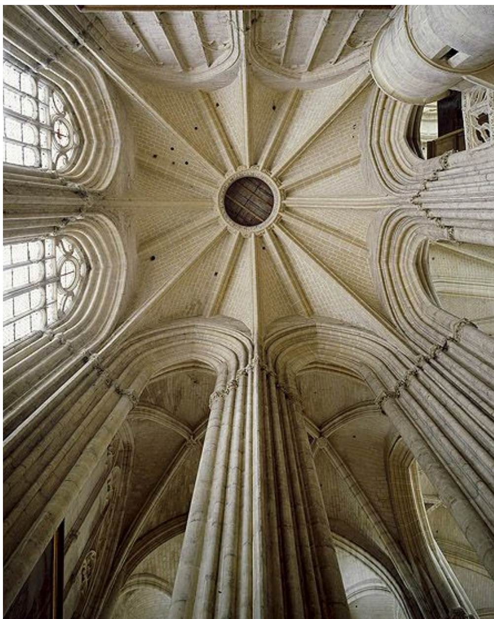
Voûte sous la tour nord.
