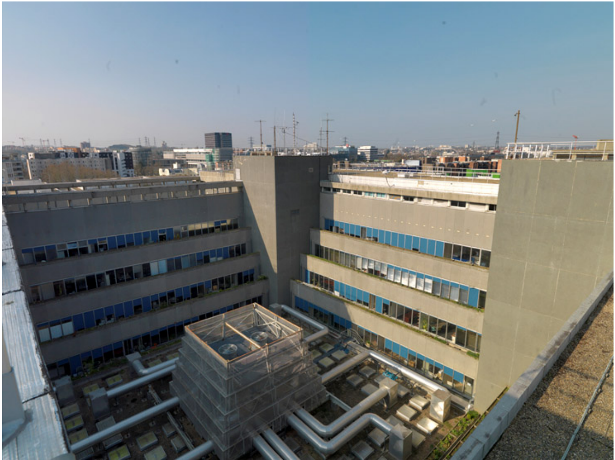
La cour intérieure de la préfecture et son réseau de canalisations
