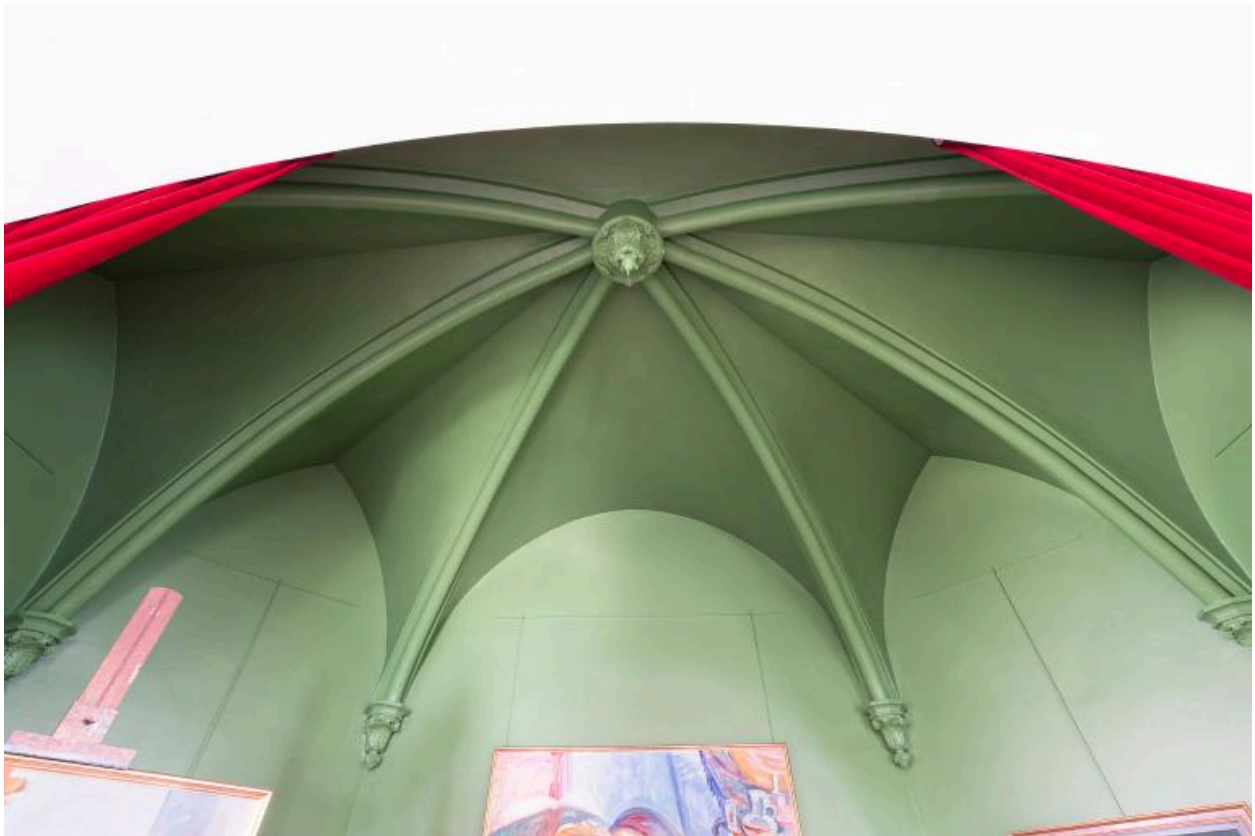
Vue des voûtes de l'abside
