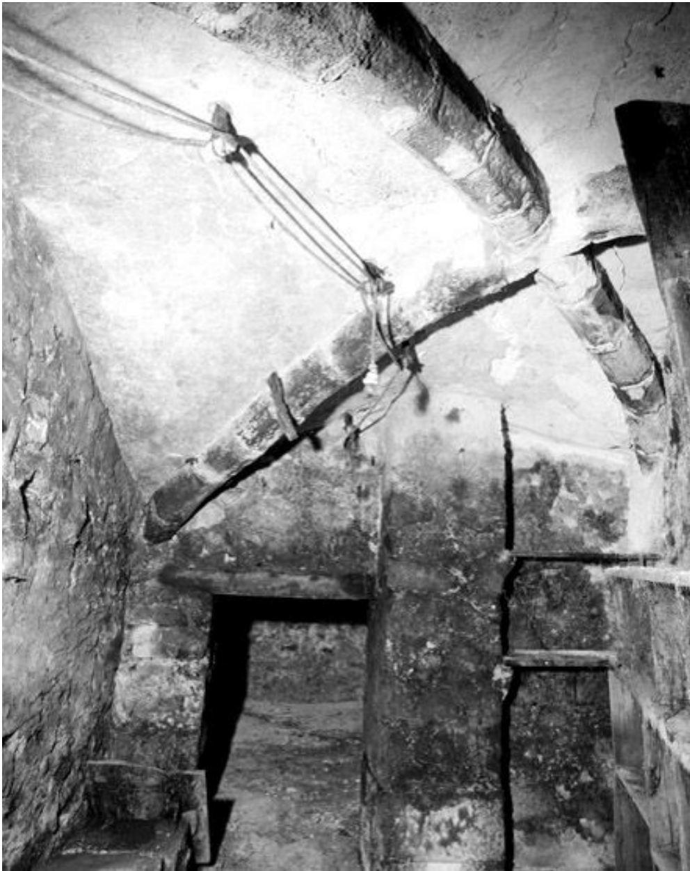
La cave médiévale : la travée sud, vue depuis le sud. Dans le fond, accès à l'espace principal de la cave. A droite, le mur longeant la rue Eugène-Briais.
