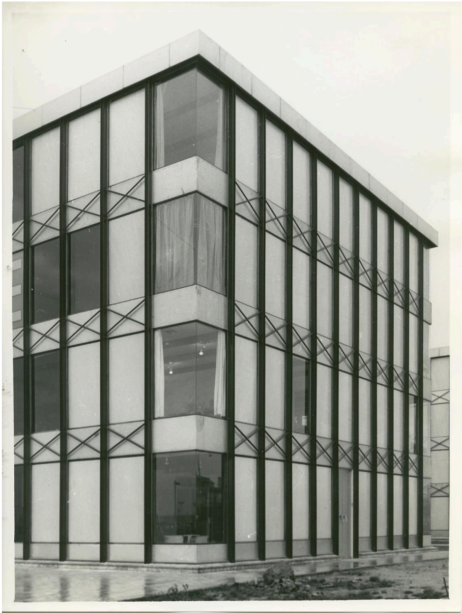
1961, le siège d'Air France ou bâtiment 363
