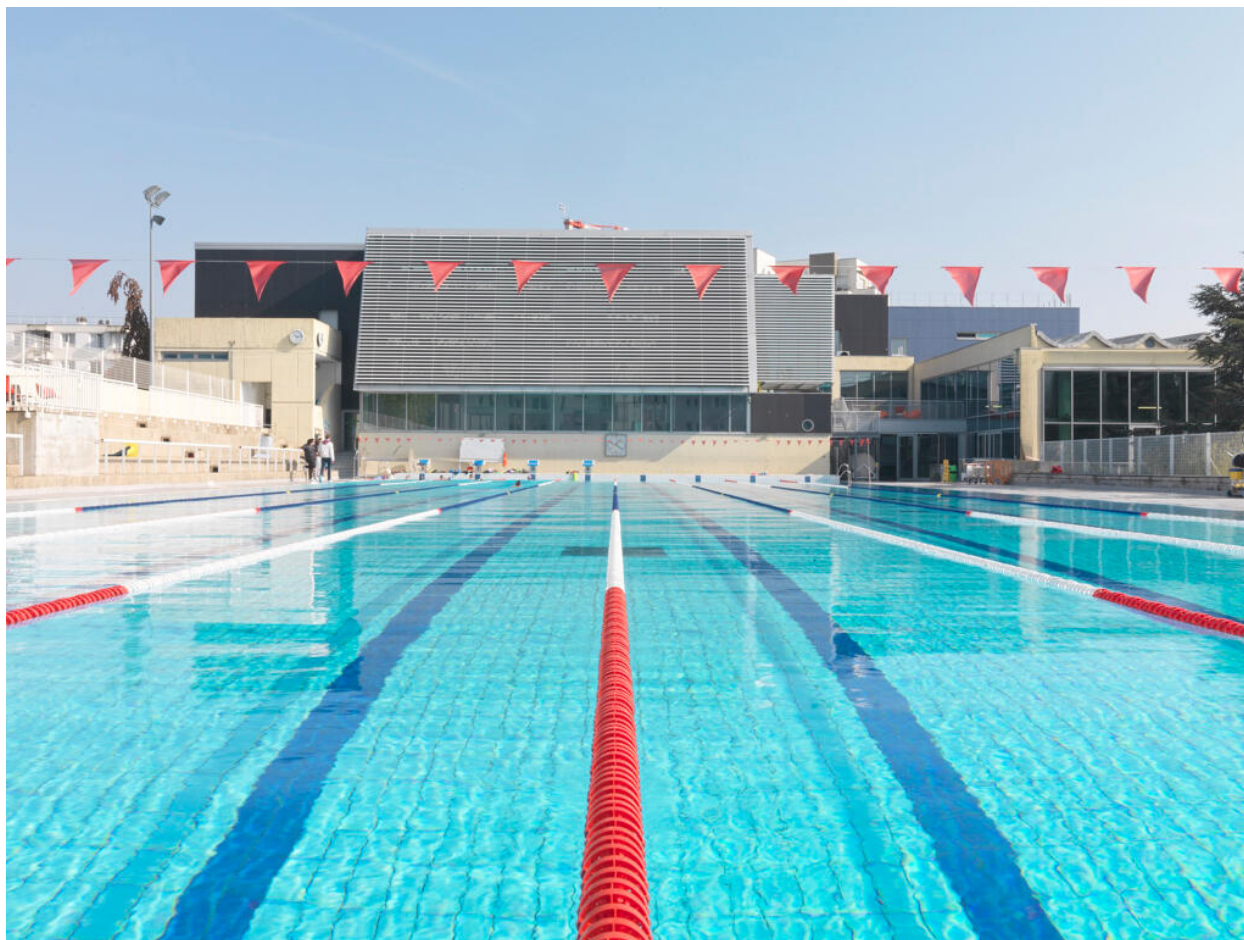
Le stade nautique Youri Gagarine. Bassin olympique avec vue sur la couverture de la fosse à plonger.
