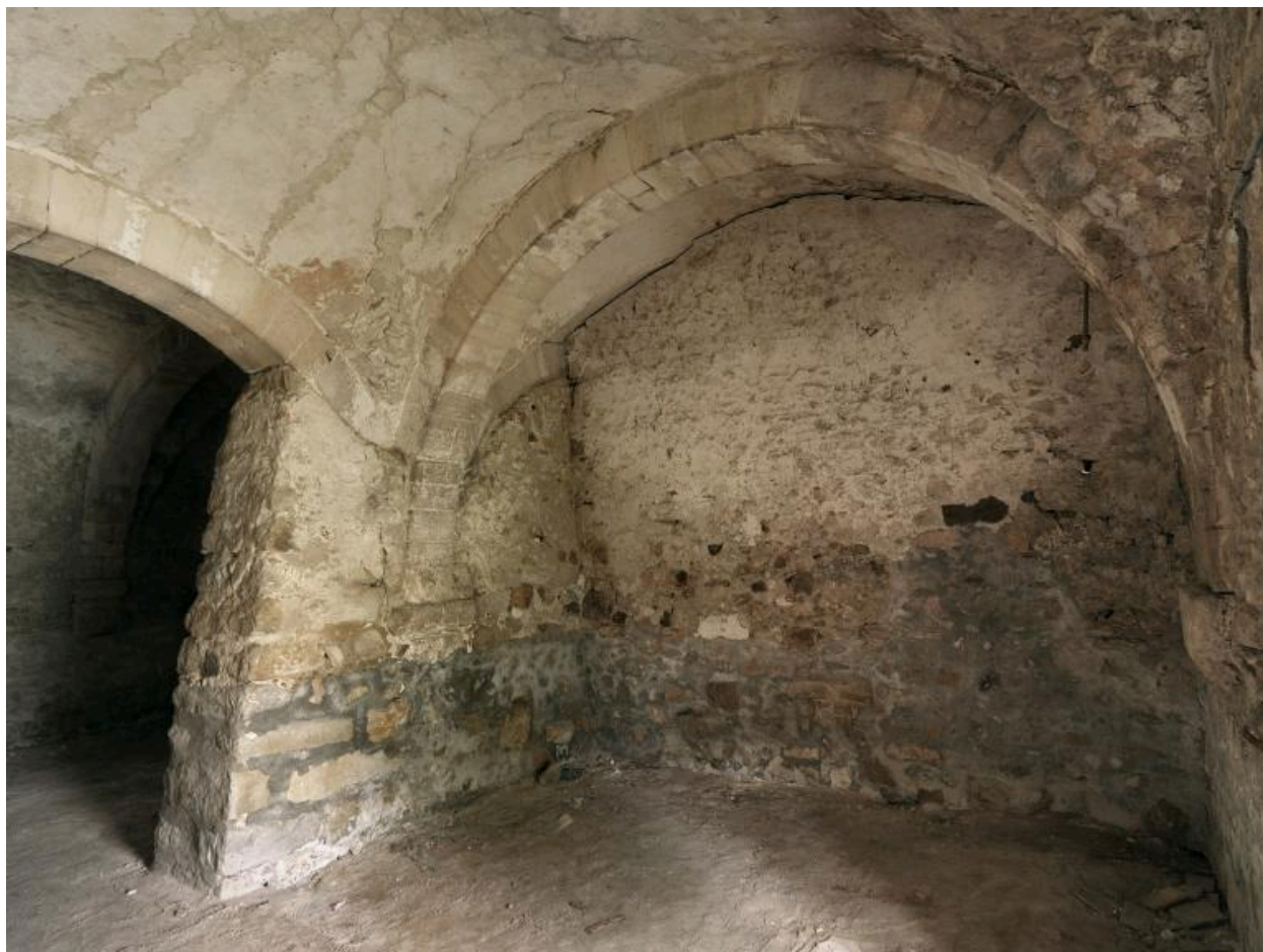
Vue sur le mur nord de la salle 3 de la grange des Beauvais depuis l'angle sud-est.
