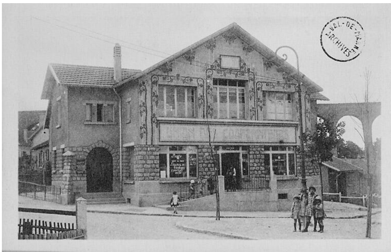
Bâtiment de l'Union des Coopérateurs. Cité jardin dite de l'Aqueduc
