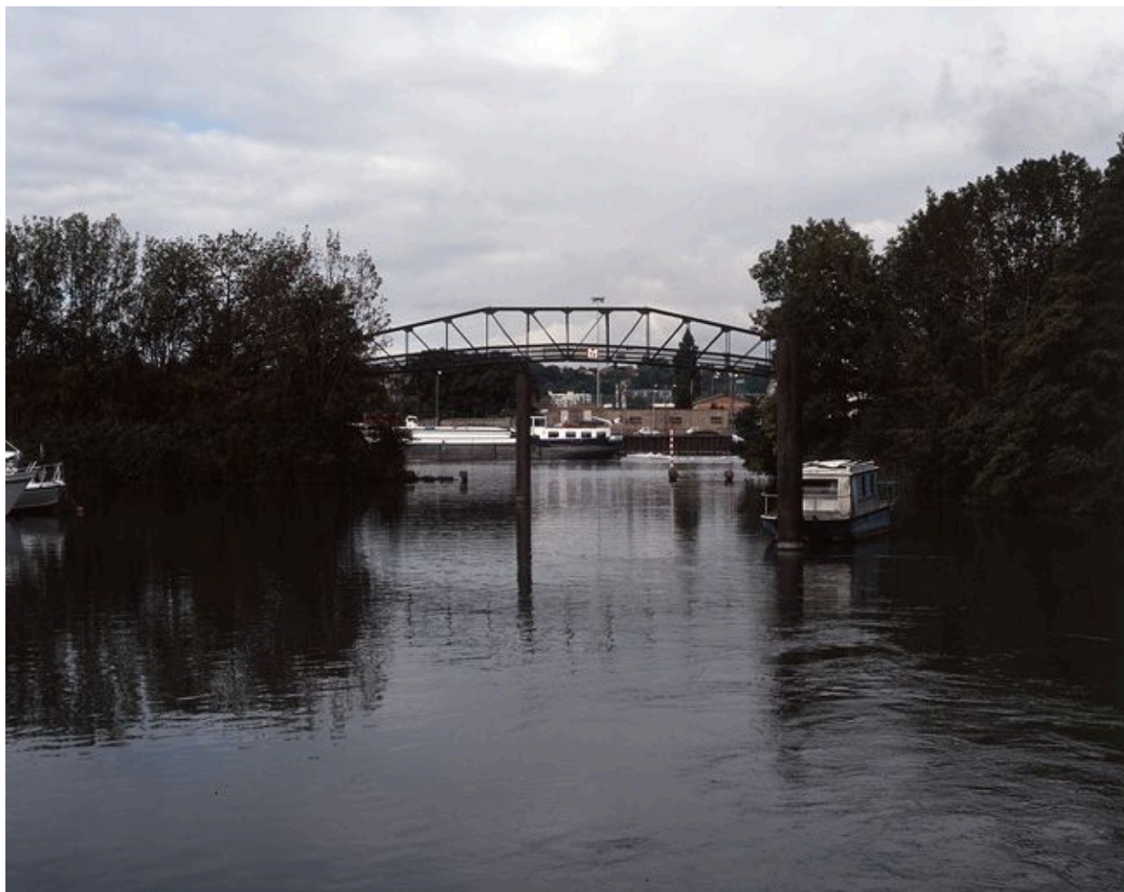
La passerelle métallique du port de plaisance, parallèle au cours de de la Seine.
