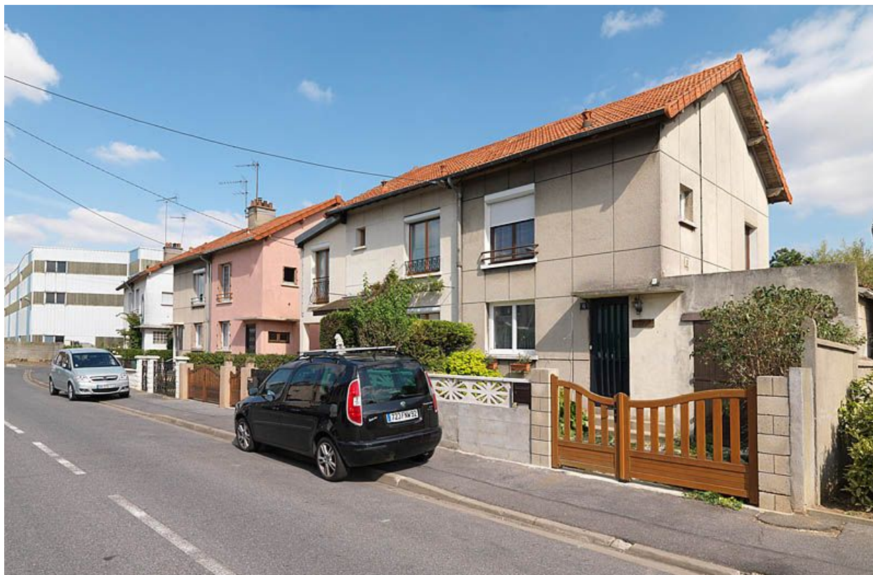
Orly, maison jumelée, 6-8 rue Georges Baudelaire. Vue d'ensemble.
