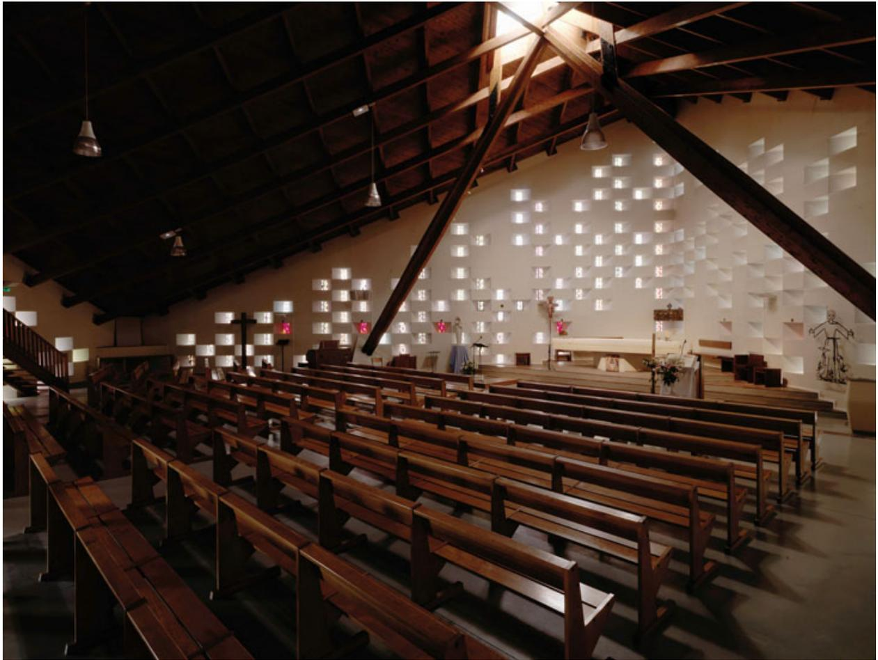
Vue intérieure. Les parois sont percées d'ouvertures ébrasées laissant perler l'éclairage naturel, dont l'intensité varie avec le jour. La charpente lamellée-collée est axée sur la diagonale.
