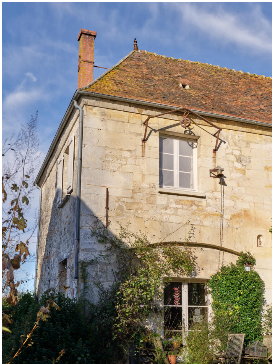
Détail de la façade principale de la maison.
