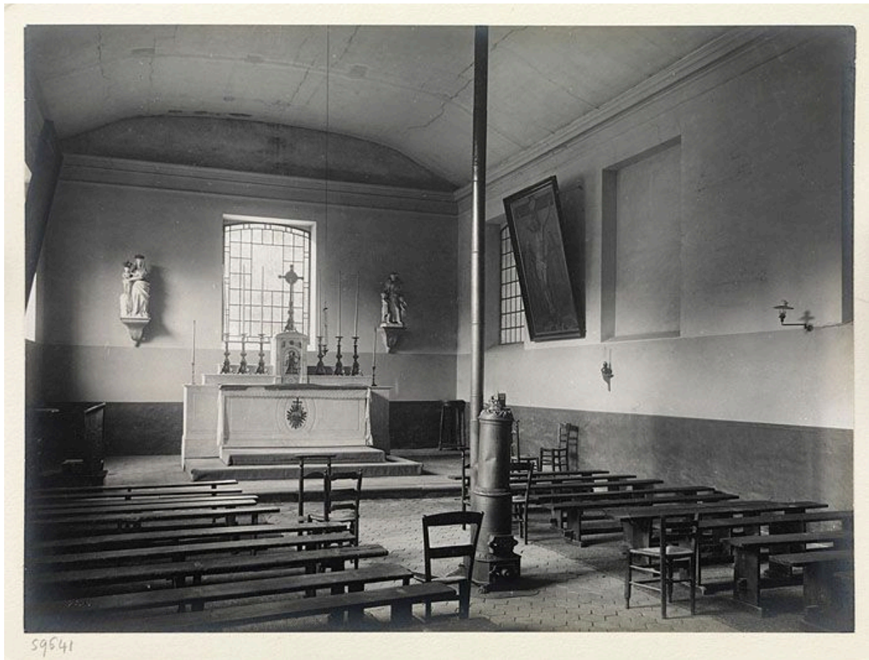
Vue intérieure de la chapelle. Photographie, 1911-1912. (Médiathèque Luxembourg, Meaux. Fonds Endrès )
