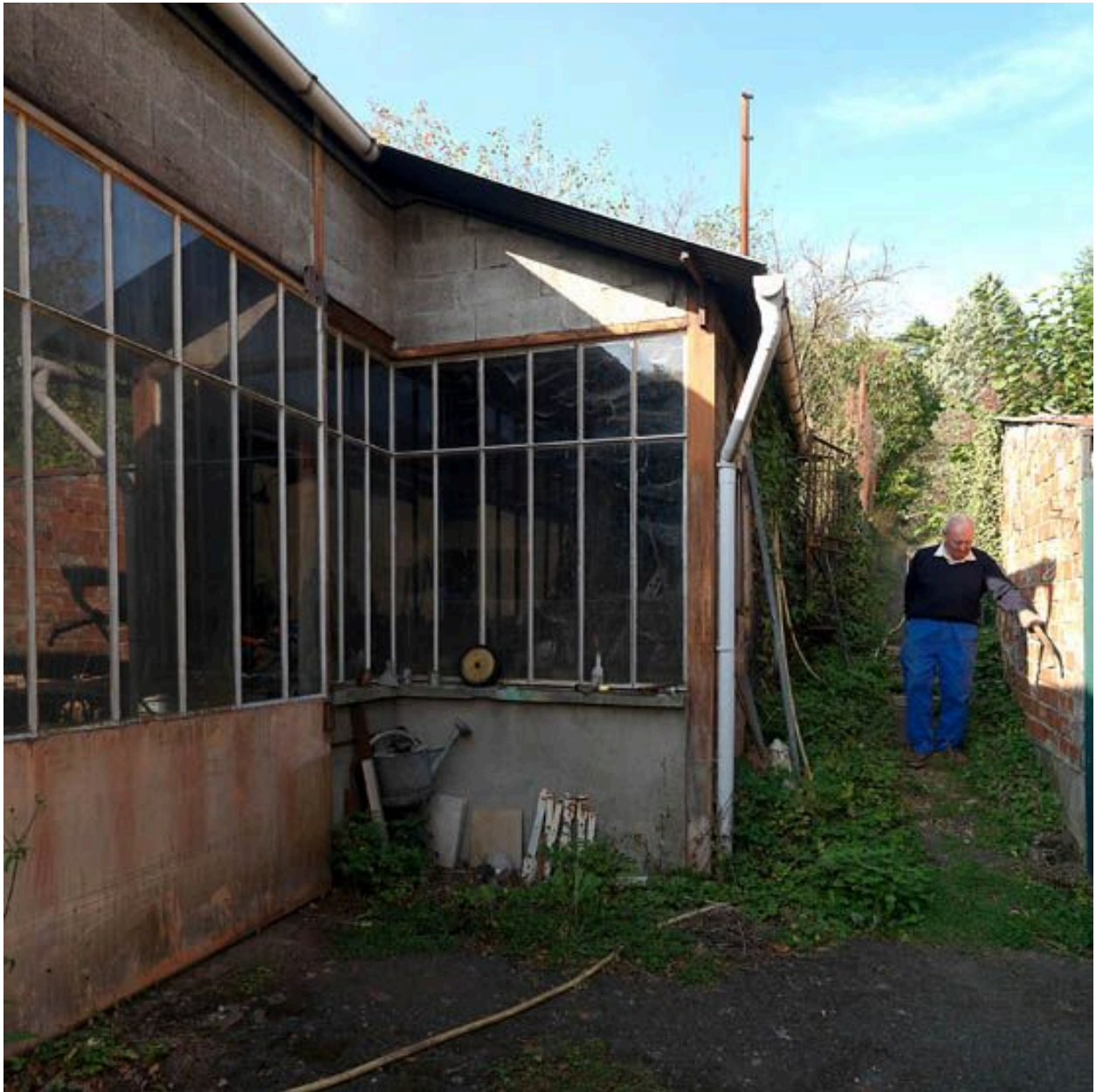
Façade orientale de l'atelier, donnant sur la cour.
