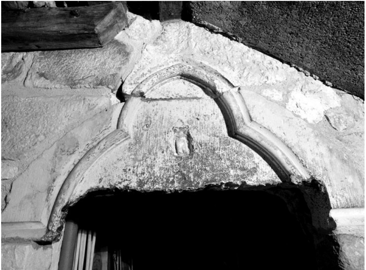
Immeuble du 11 rue Guy-Baudouin, avec cave en berceau et éléments anciens en remploi. Détail du tympan remployé sur la cour.
