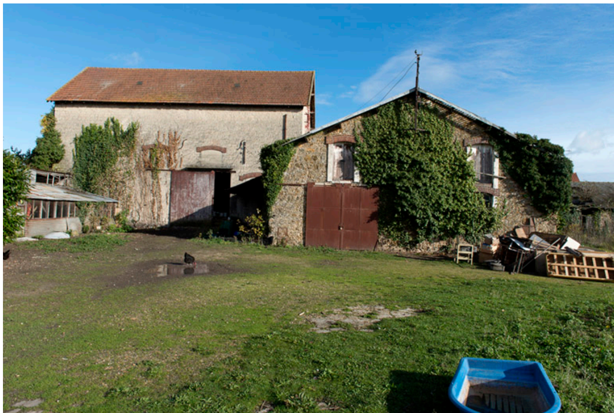
Bâtiments agricoles au nord est de la cour.
