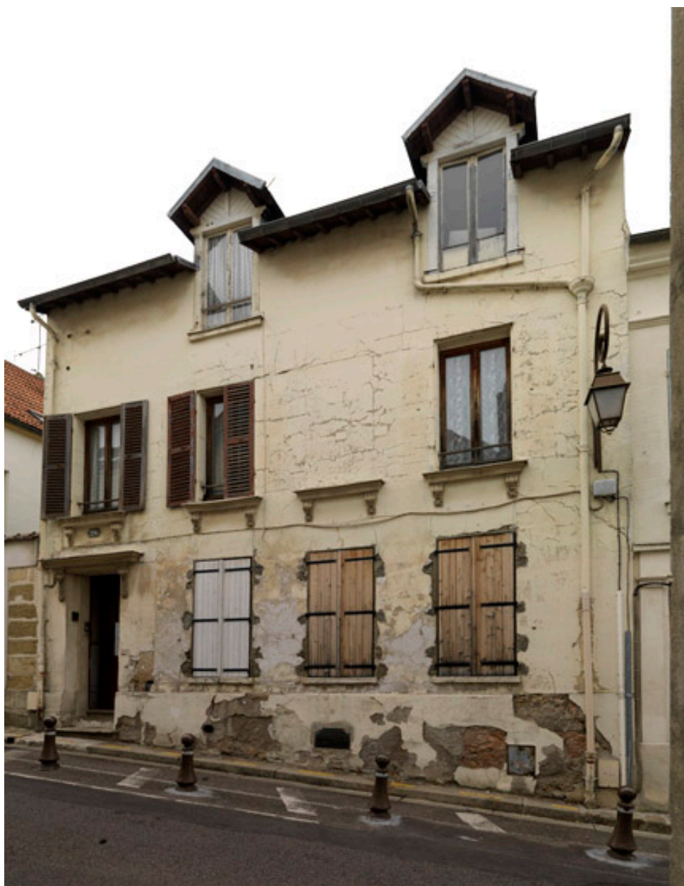
Maison de bourg, 26, rue Sangle. Vue d'ensemble de la façade.
