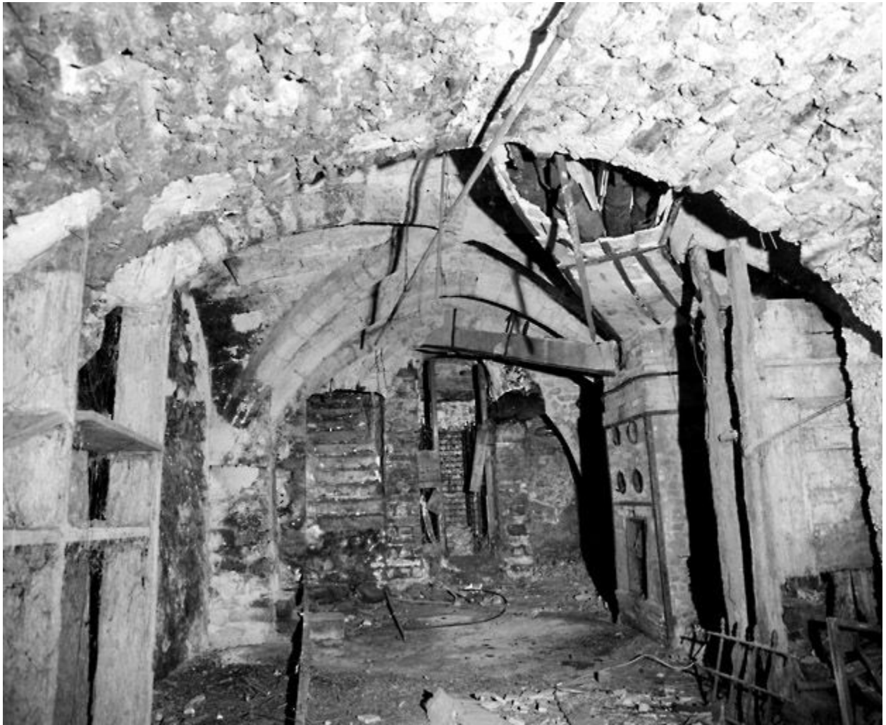
La cave du 18-20, rue Paul-Doumer : vue depuis l'est.
