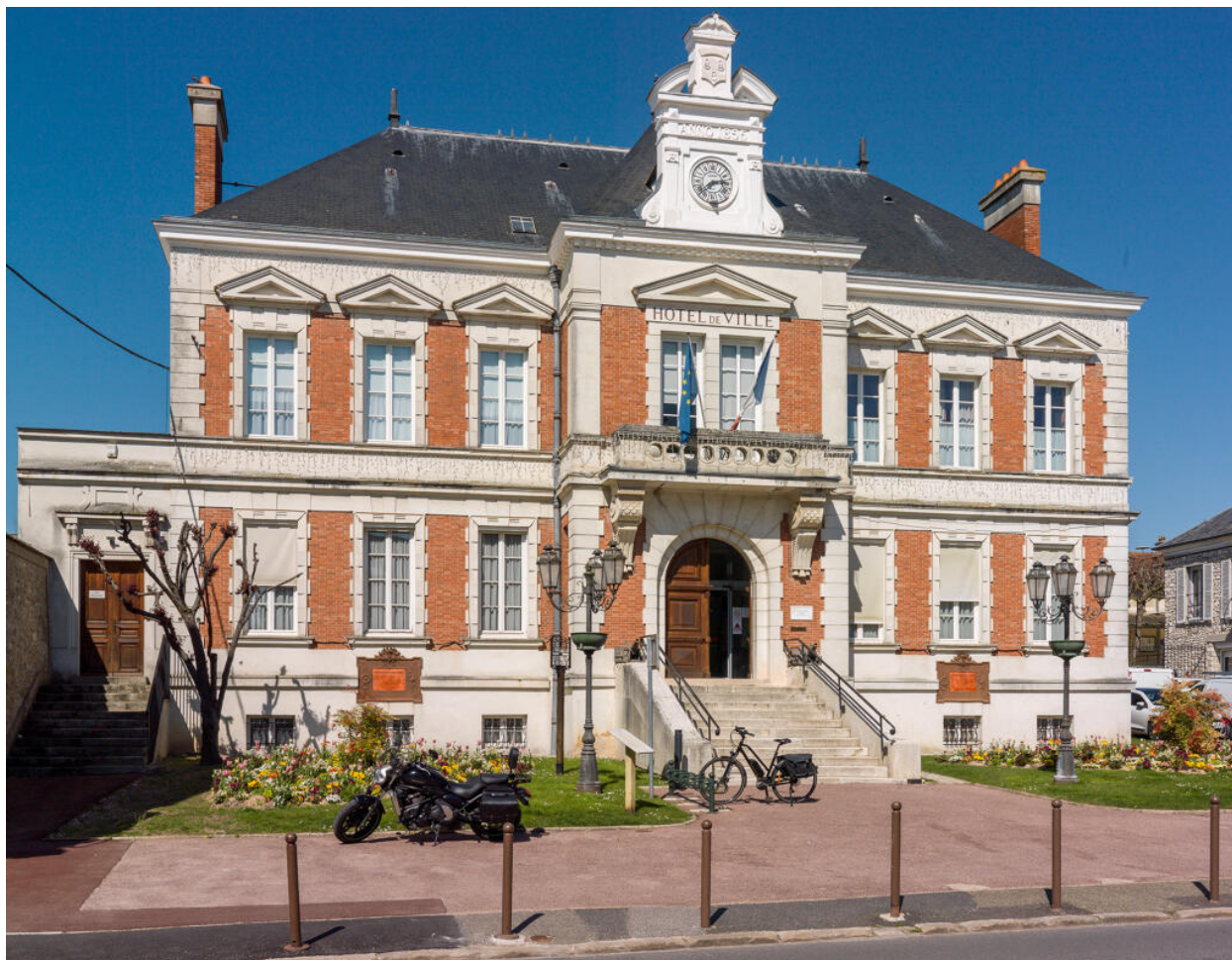
Vue de l'angle sud-ouest de la façade principale de l'Hôtel de Ville de Milly-la-Forêt (orientée au sud).
