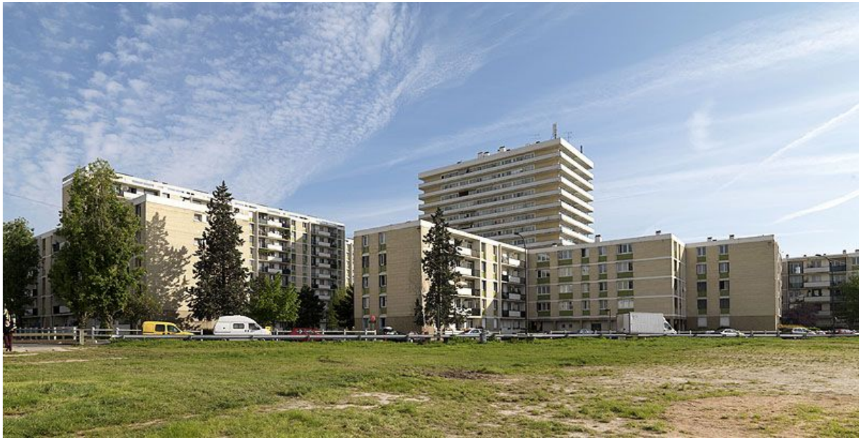
Vitry-sur-Seine, cité dite Cité Gagnée, rue Gagnée, rue Champolion, rue de la Fraternité . Vue d'ensemble.
