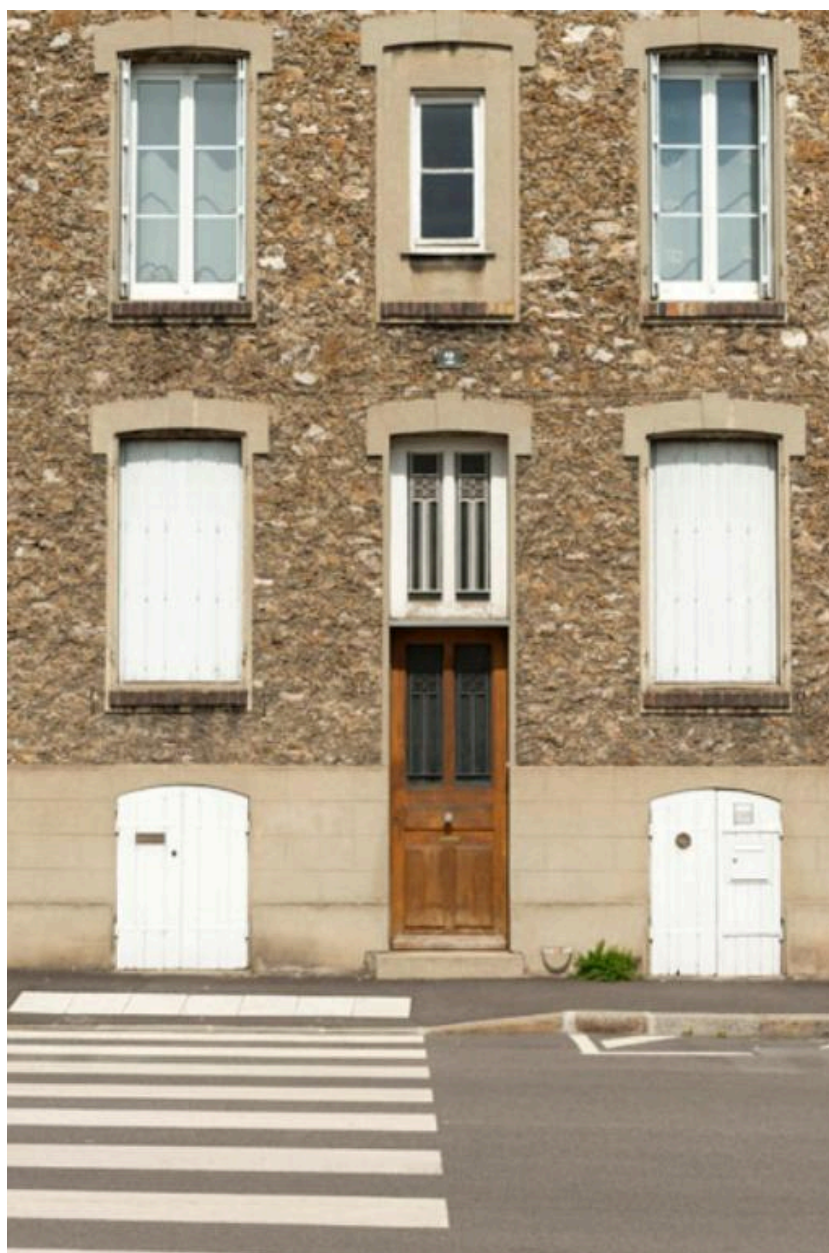
Détail de la façade du 2 rue Saint-Roch. On voit les entrées extérieures de caves.
