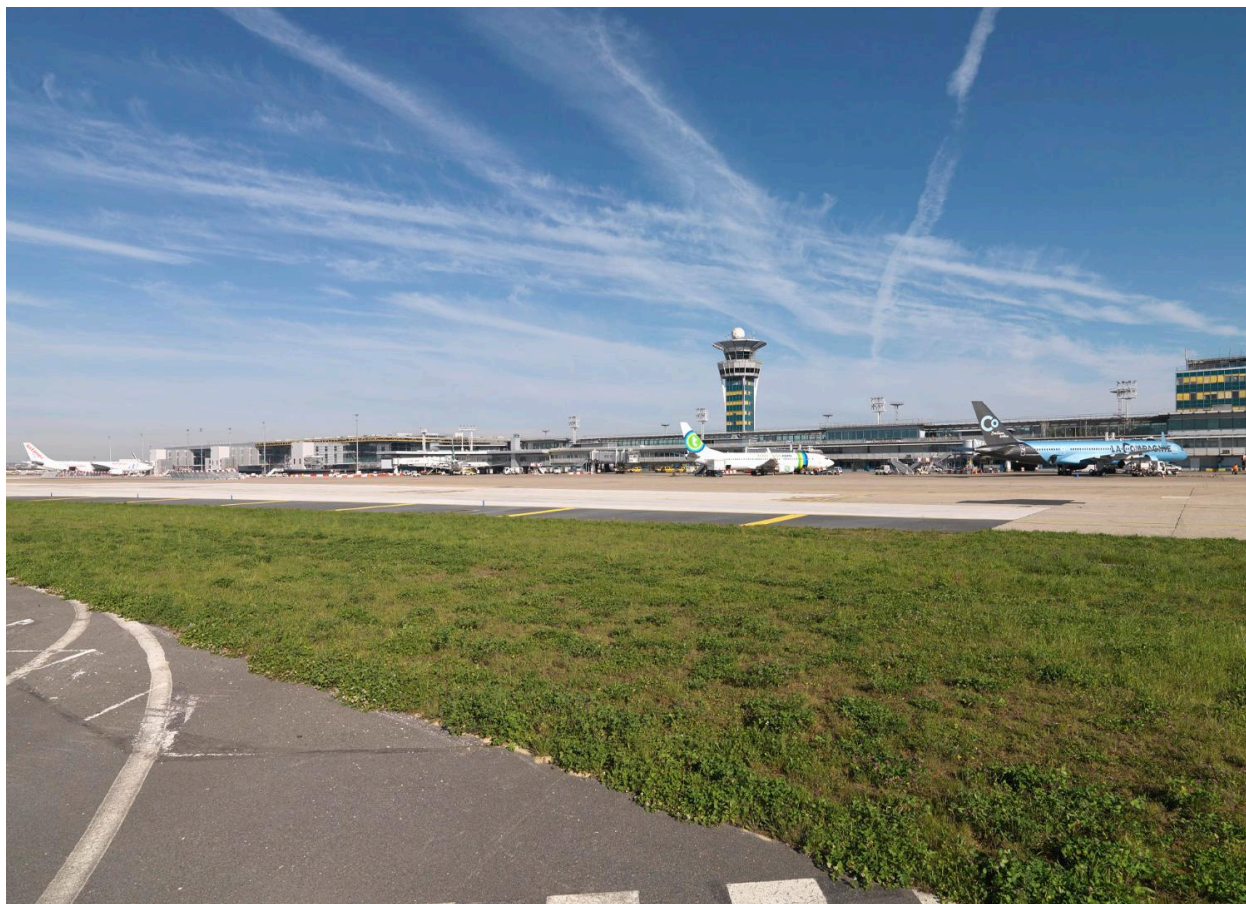
2018, la jetée ouest, la tour de contrôle et le chantier d'Orly 3 vus depuis le sud est.
