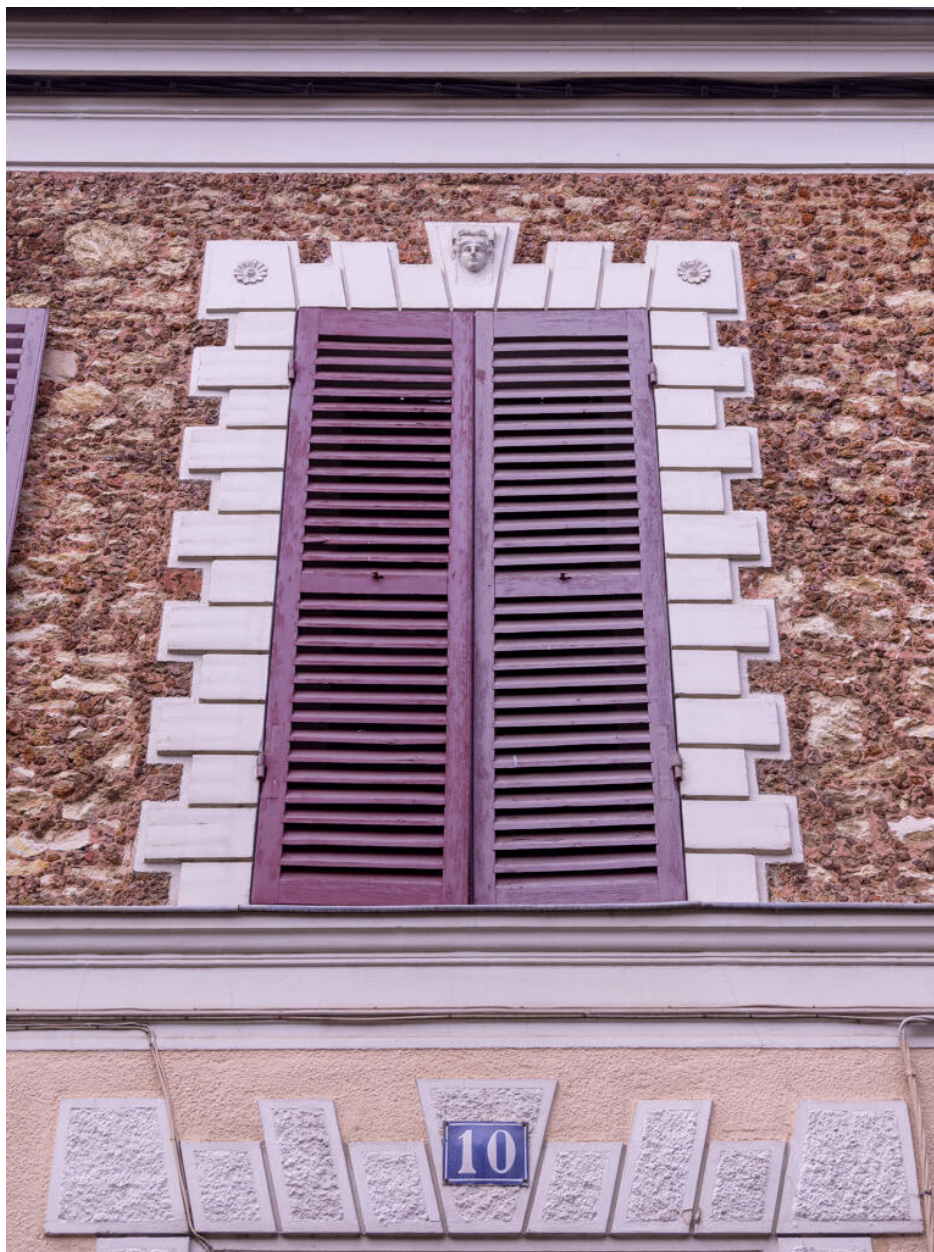
Vue de détail d'un baie de l'étage.
