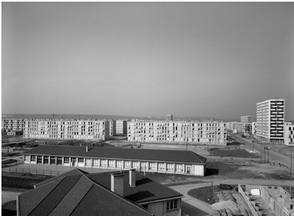
Vue générale de l'opératio. Au premier plan : le groupe scolaire Nicolas Apper. Photographie, 1961. (Ministère de l'Ecologie, MRU 36808009)
