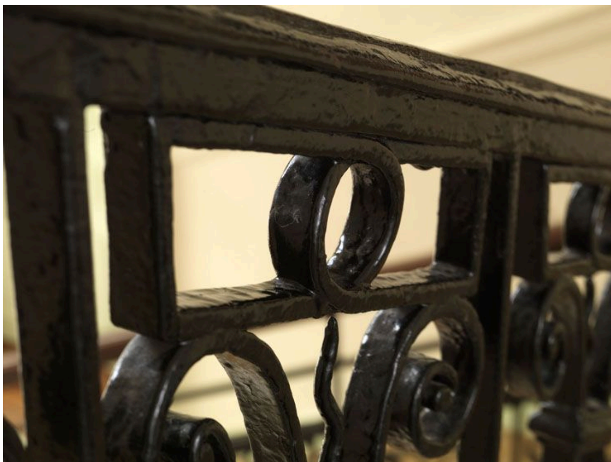
Détail de l'abaque du balustre de fer.
