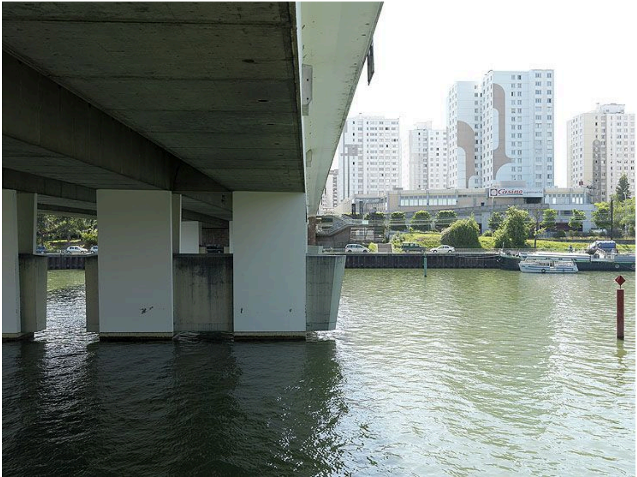
Choisy-le-Roi. Pont de Choisy (n°2). Détail d'une pile, au loin les tours du centre-ville.
