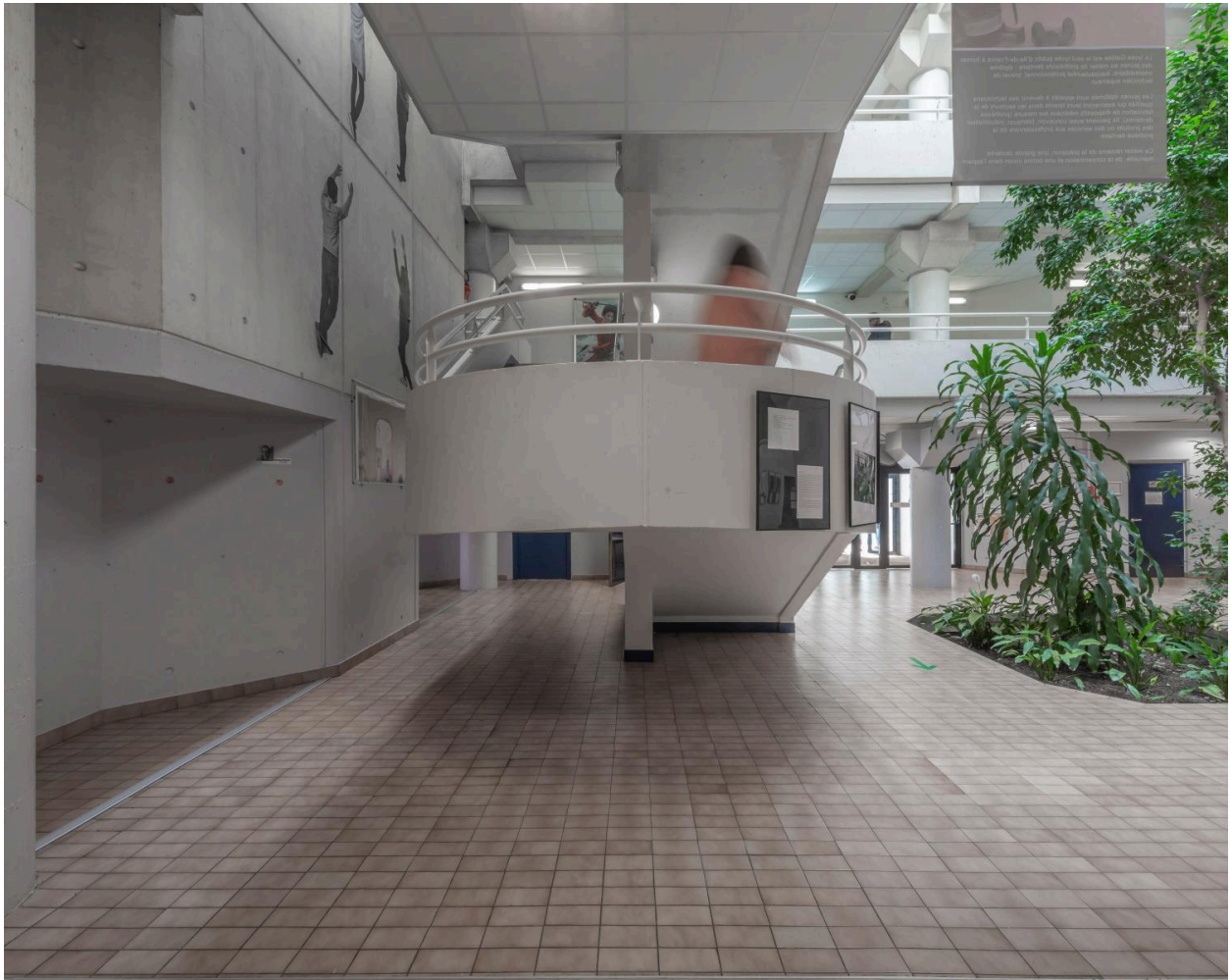
Détail du départ de l'escalier rampe sur rampe qui dessert les différents niveaux de l'établissement depuis le hall.
