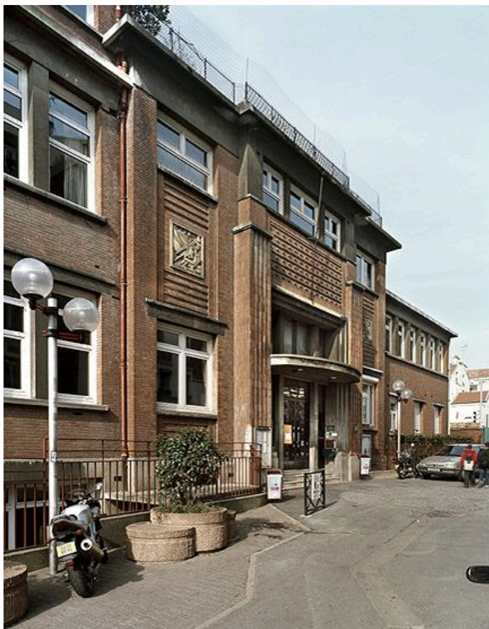
Vue d'ensemble de la façade.
