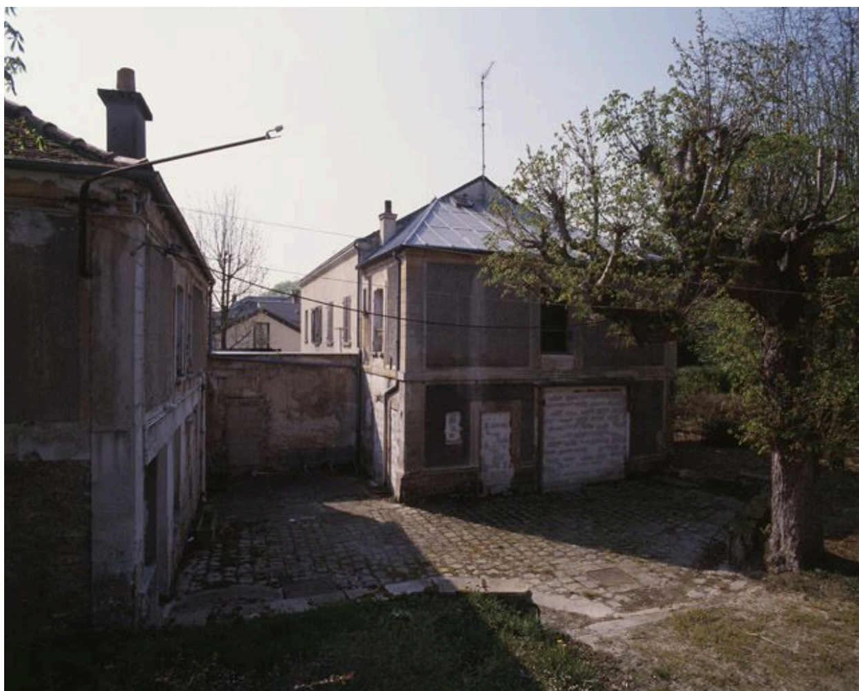
Vue de la partie des communs située au nord-est de la maison (côté boulevard Henri-Barbusse).
