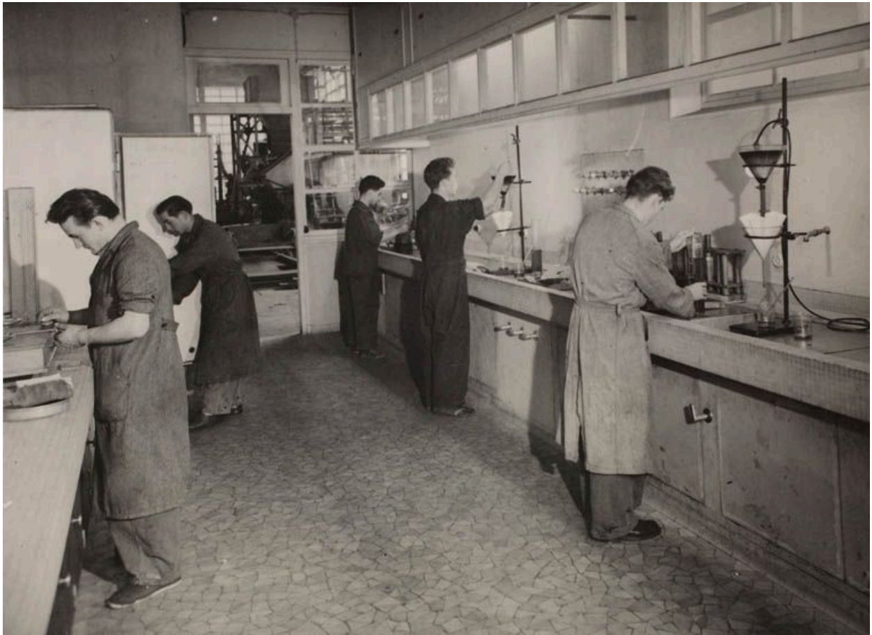
Vue intérieure de la station d'essai, salle du laboratoire d'analyse des charbons et des minerais. Photographie. (AD Seine-et-Marne, 256J3)
