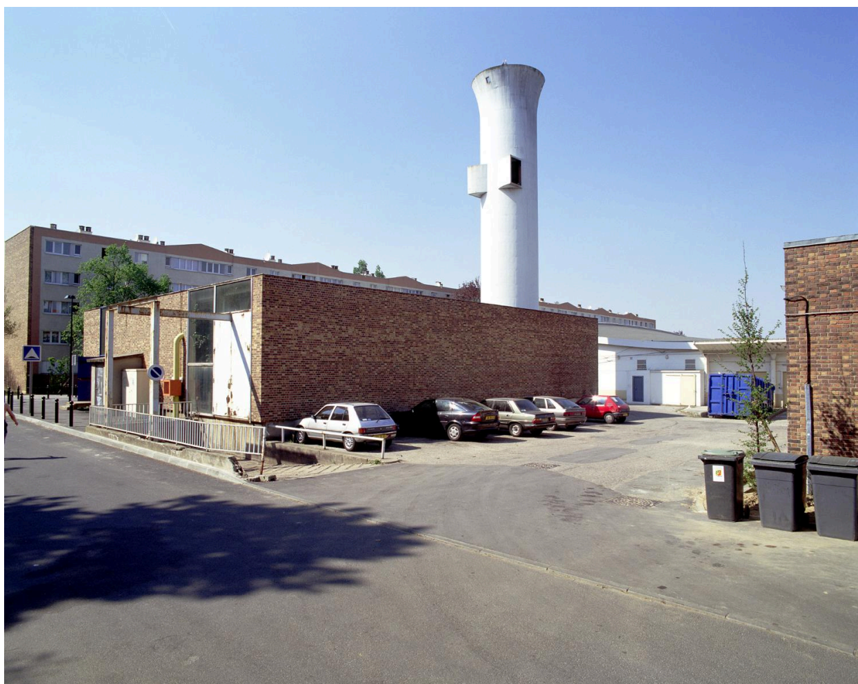
Vue de la chaufferie, située près du supermarché.
