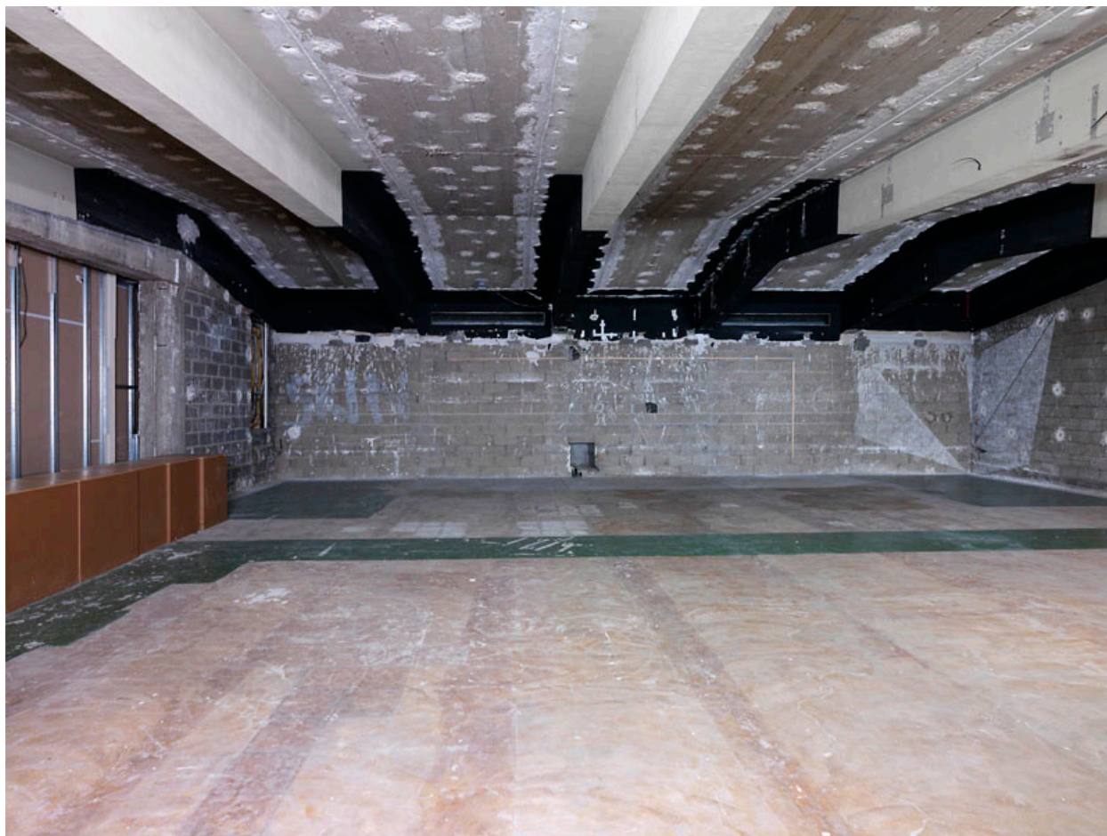
Le théâtre en attente de rénovation.
