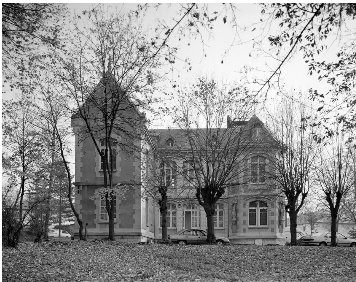
Façade ouest de l'orphelinat
