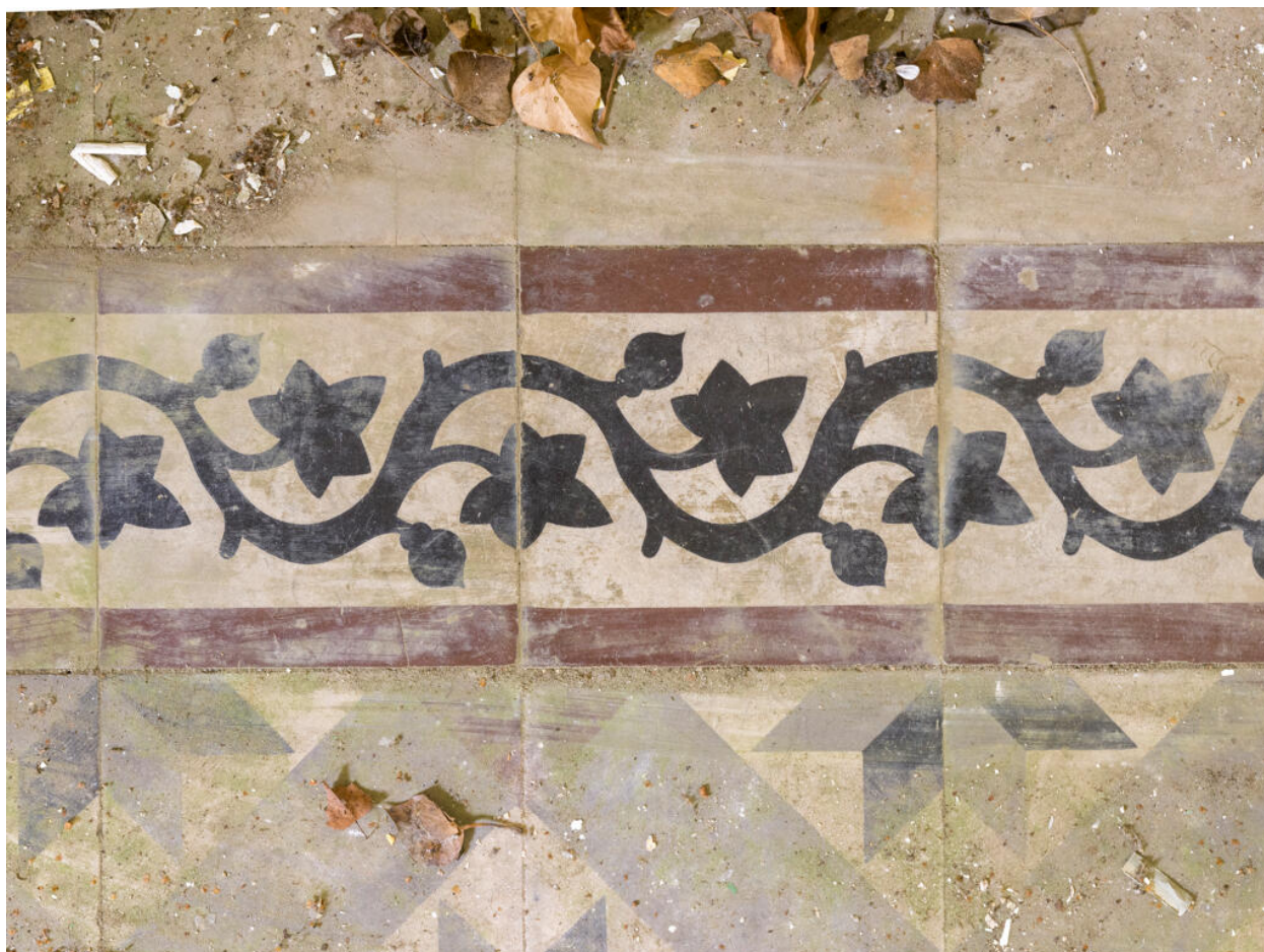
Maison d'Octave Allaire, frise ornementale à rinceau végétal ornant le sol des pièces du rez-de-chaussée en carreaux de ciment
