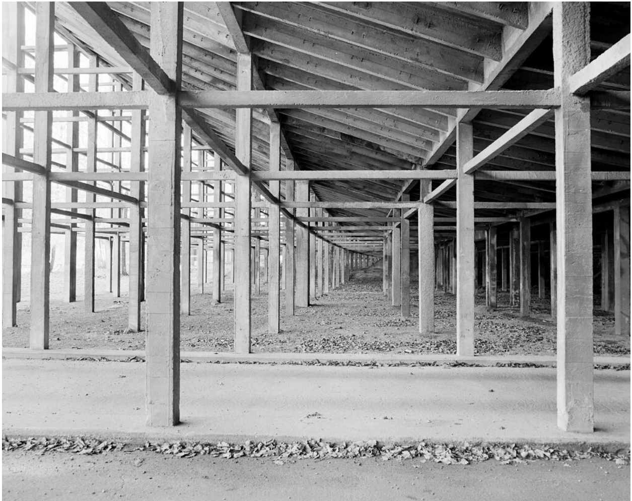
Détail du sous-bassement de l'anneau de vitesse. Autodrome
