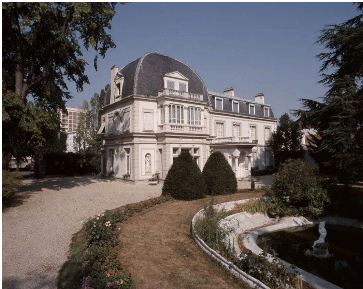
Façade côté parc.
