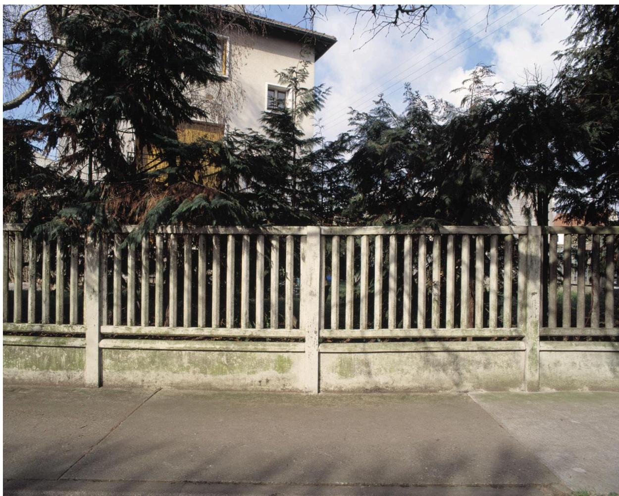
Clôture en ciment du type ""Lissages à deux barres"".
