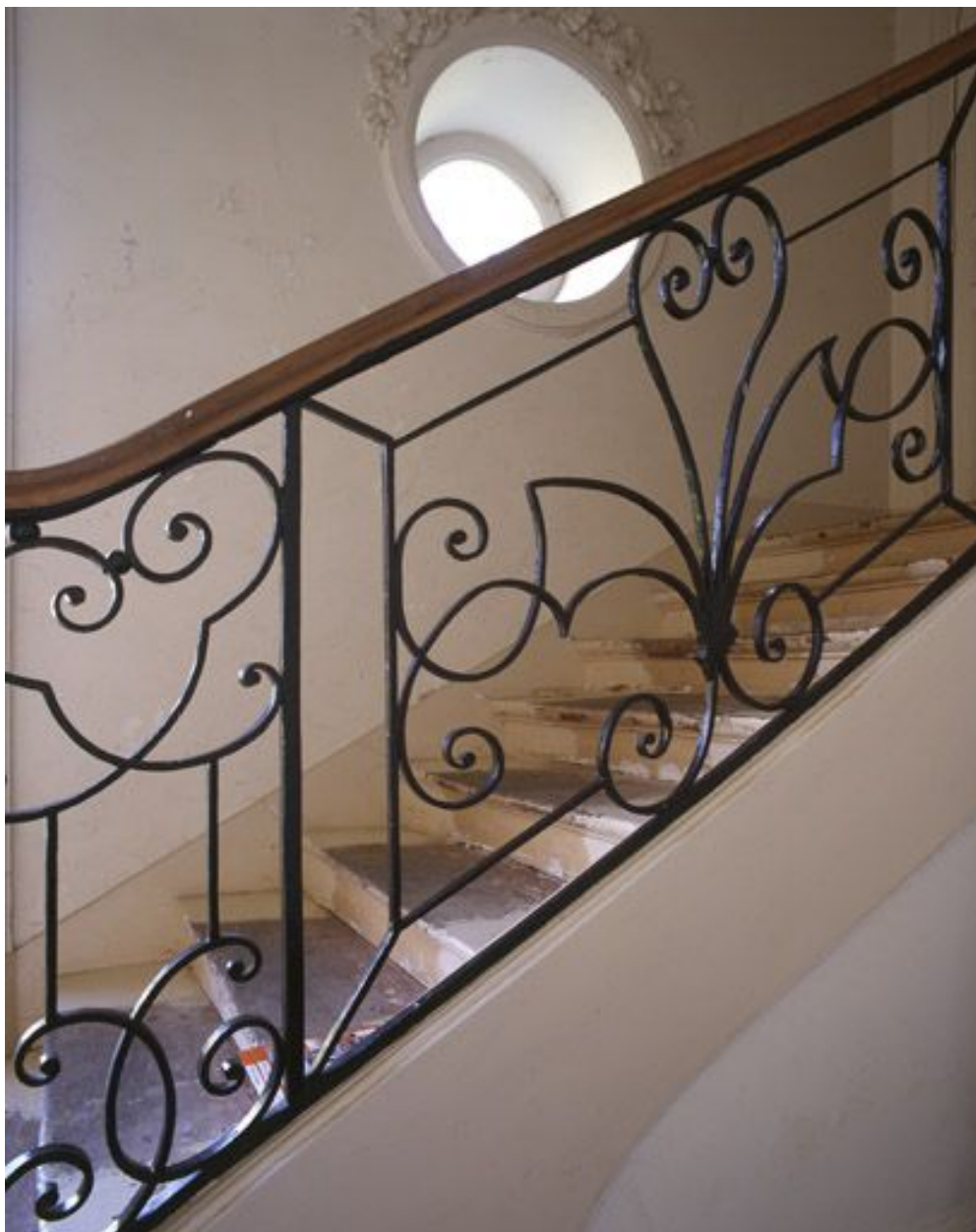
Détail de la rampe de l'escalier intérieur.
