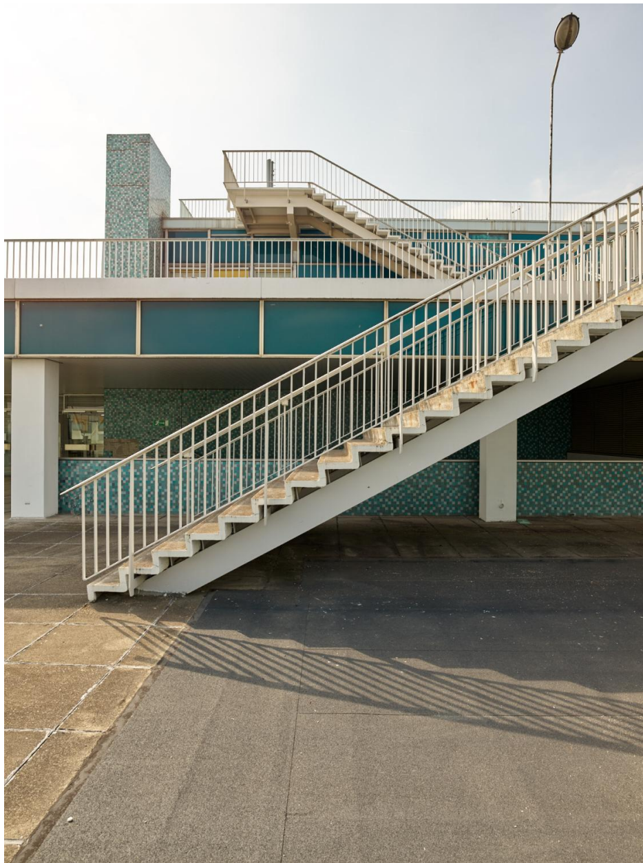
2018, terrasses, circulation verticale: escalier est, 4ème étage.
