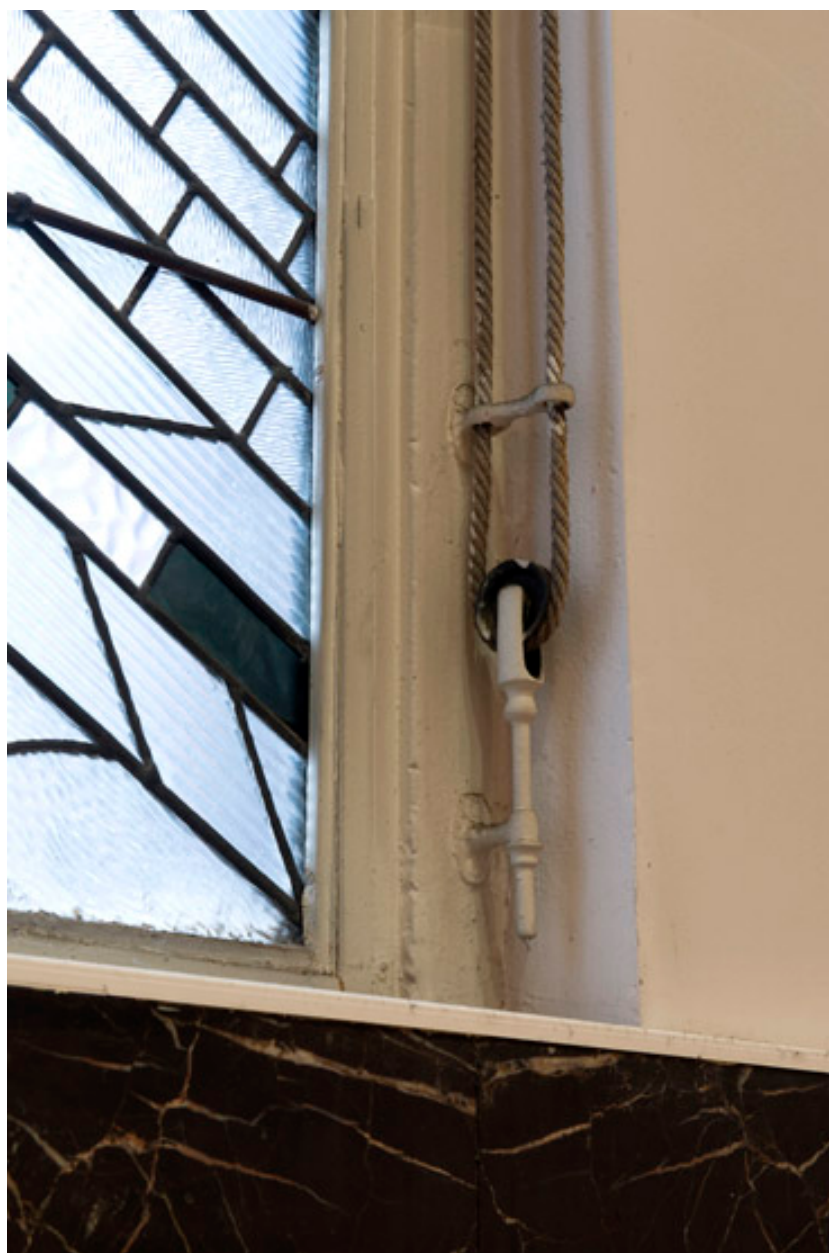
Détail du mécanisme d'ouverture des fenêtres.
