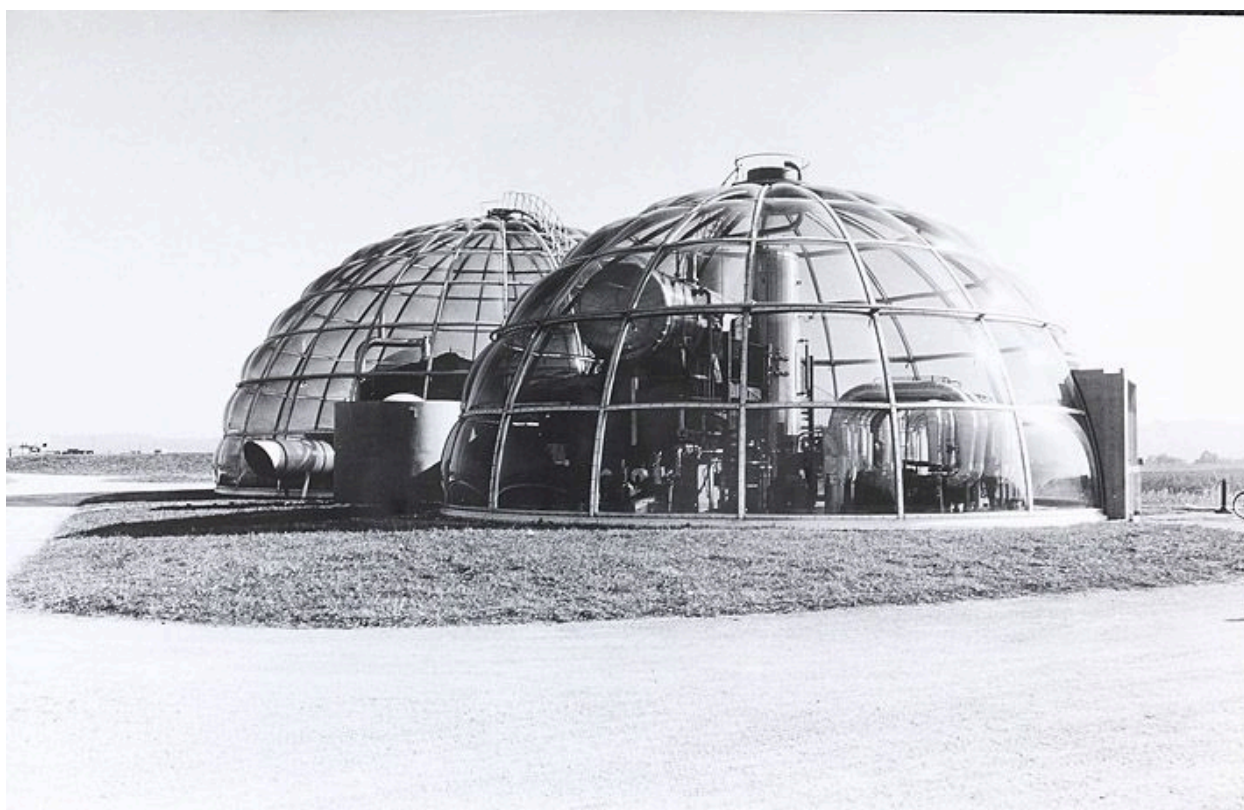
Chaufferie de Meaux en construction. (Cité de l'architecture et du patrimoine. fonds DAU 173/1)
