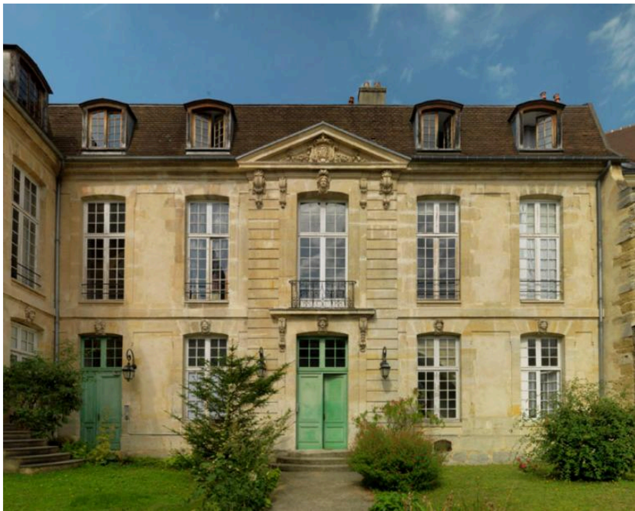
Vue de la façade sur cour.
