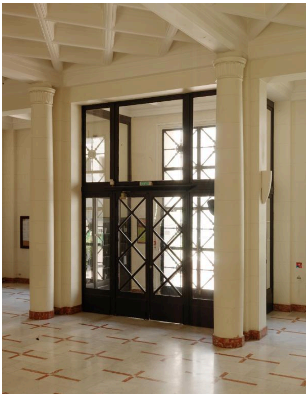
Le sas d'entrée, vu du côté du hall.
