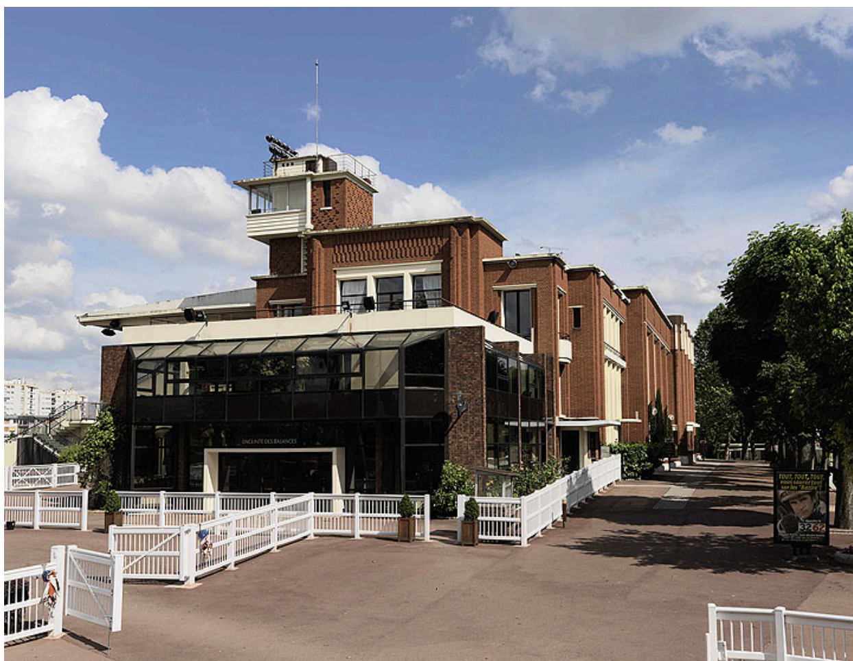
Tribune du pesage vue en perspective vers l'entrée de la salle de pesage.
