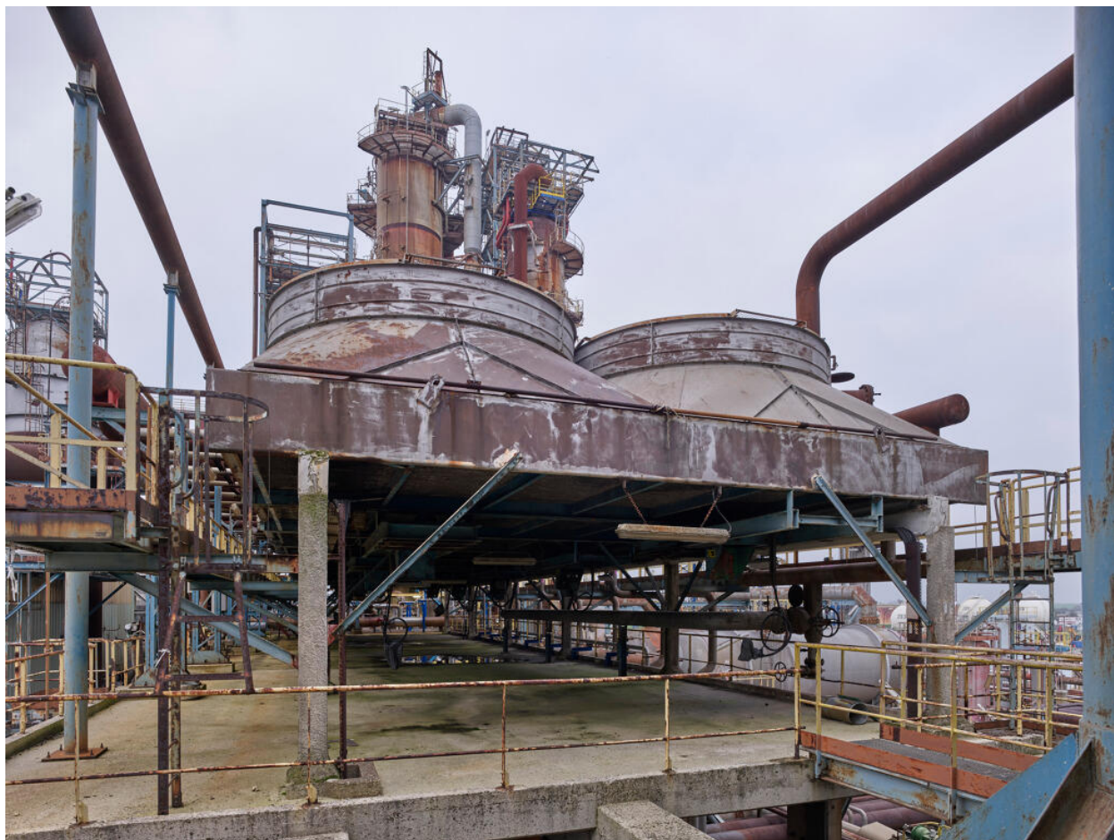
Unités Est - Zone FCC (Unité 651). Batterie complète des aéroréfrigérants EM 1001 sur l'unité FCC (Unité 651).
