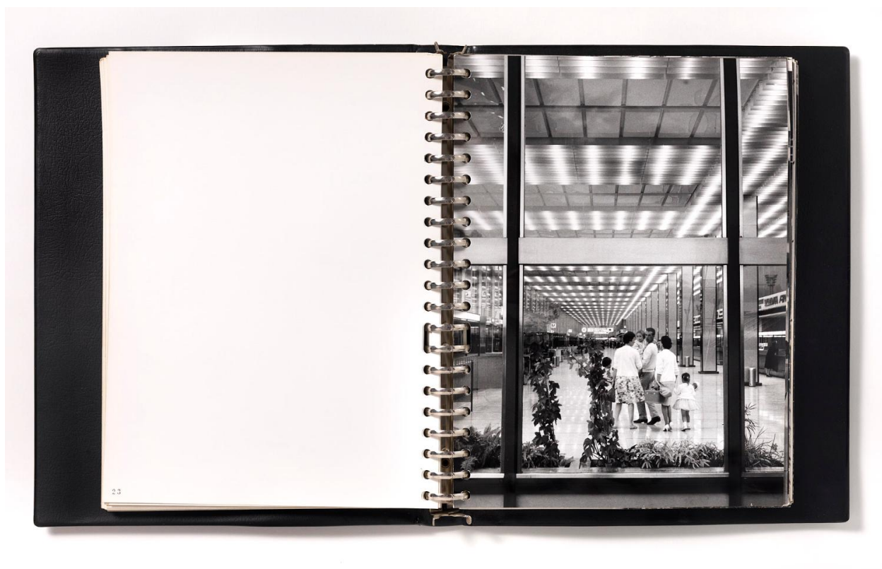
Le Grand Hall, rez-de-chaussée, "Orly Installations Terminales", album de photographies destinées à la presse édité par l'Aéroport de Paris, 1961.
