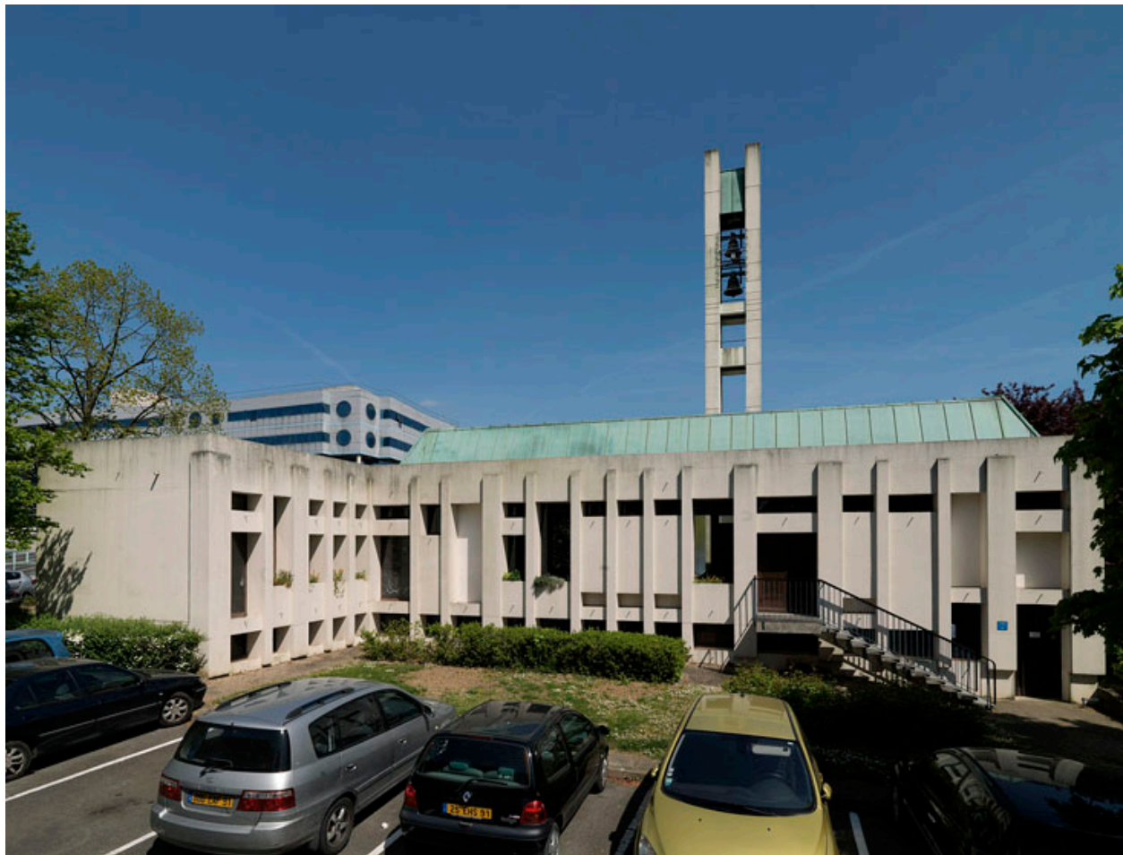
Façade principale de l'église évangélique Saint-Marc.
